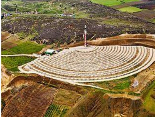
Mersin Güneş Enerji Kulesi
